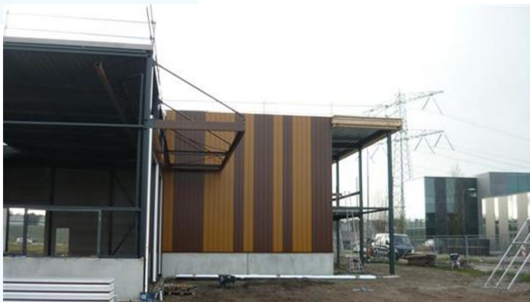
Bouwplaats A-booth Oostzaan
